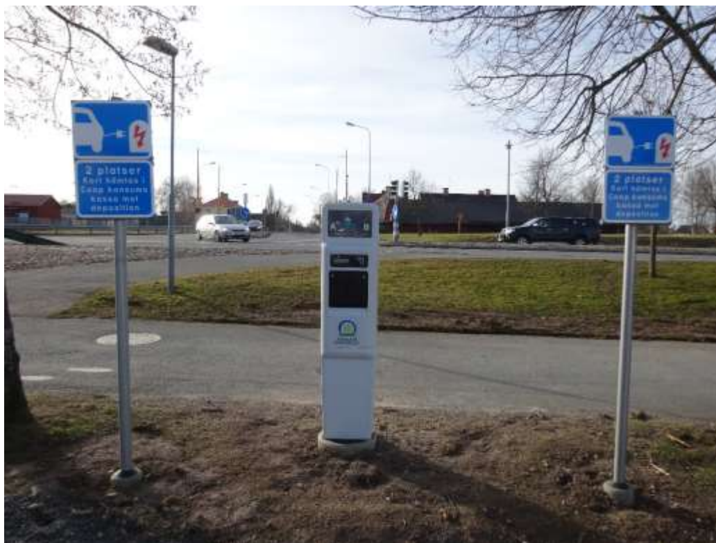
Bilden visar första laddstolpen för elbilar i kommunen som är belägen på Coop parkeringen i Eksjö.
