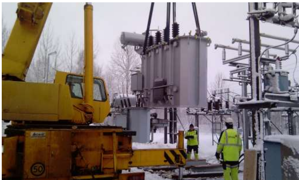
Bilden visar när T200 stationens transformator lyfts på plats för installation.
