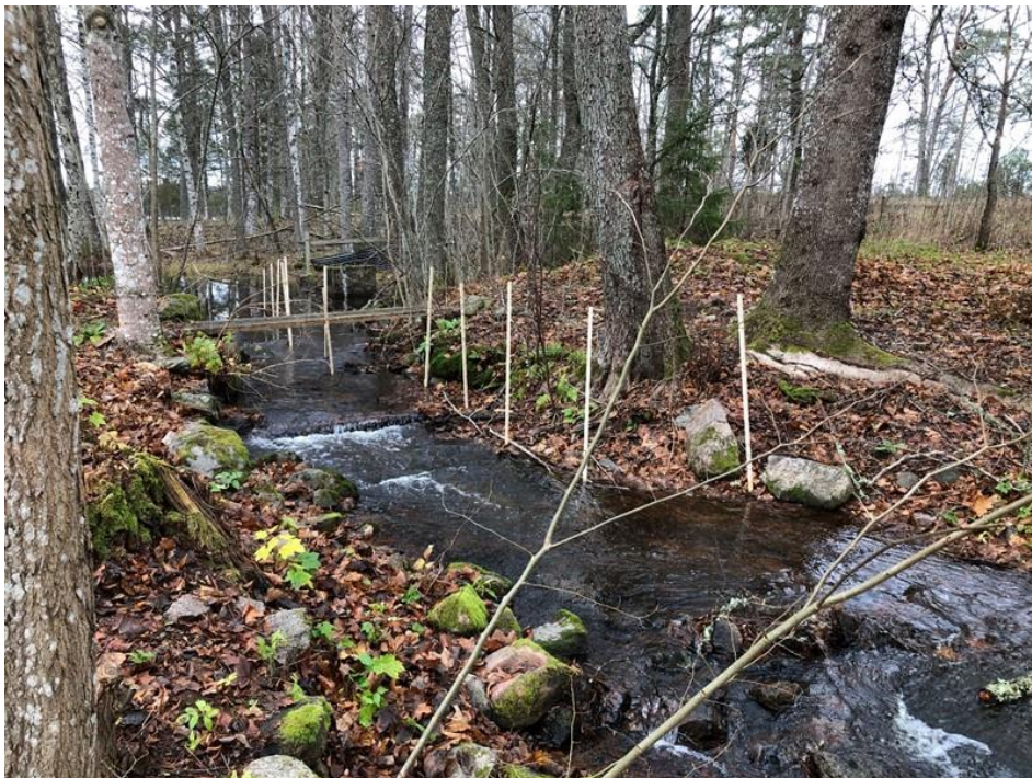
Figur 1 Utloppet från Försjön, sett från höger sida av utloppskanalen, mot sjön. På bilden syns de stäckäppar som sattes upp för att markera sektioner för inmätning av kanalen, vid platsbesök av Sweco 2024-11-14.
